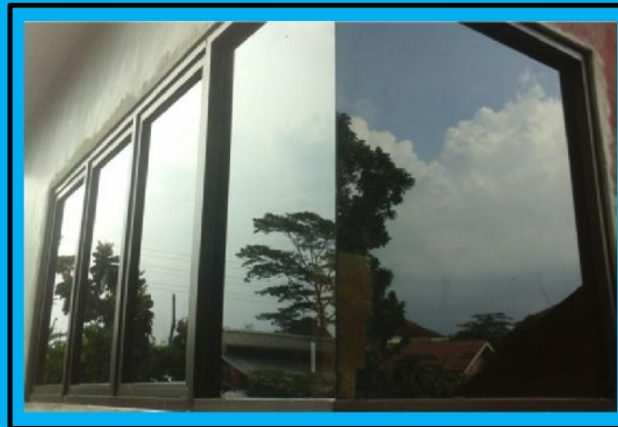
▪ PROJECT RUMAH TINGGAL
