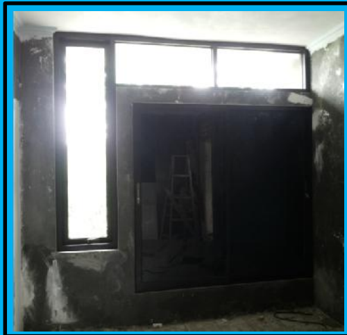
▪ PROJECT RUMAH TINGGAL
