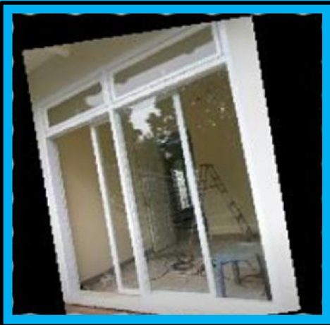
▪ PROJECT RUMAH TINGGAL
