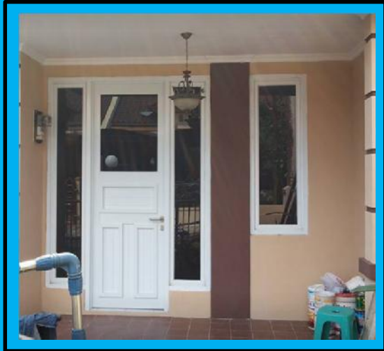
▪ PROJECT RUMAH TINGGAL
